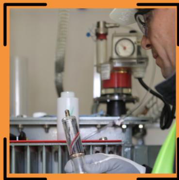
Un maintenancier réalise un prélèvement d'huile diélectrique sur l'un des transformateurs stratégiques de son client dans le cadre d'opérations de maintenance.
